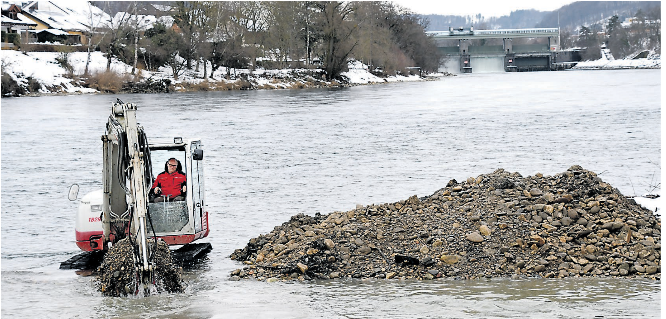
Baggereinsatz in Ufernähe, direkt bei der Mündung des Chrüzlibachs in den Rhein: Eine Buhne entsteht, im Hintergrund das Kraftwerk Reckingen.
