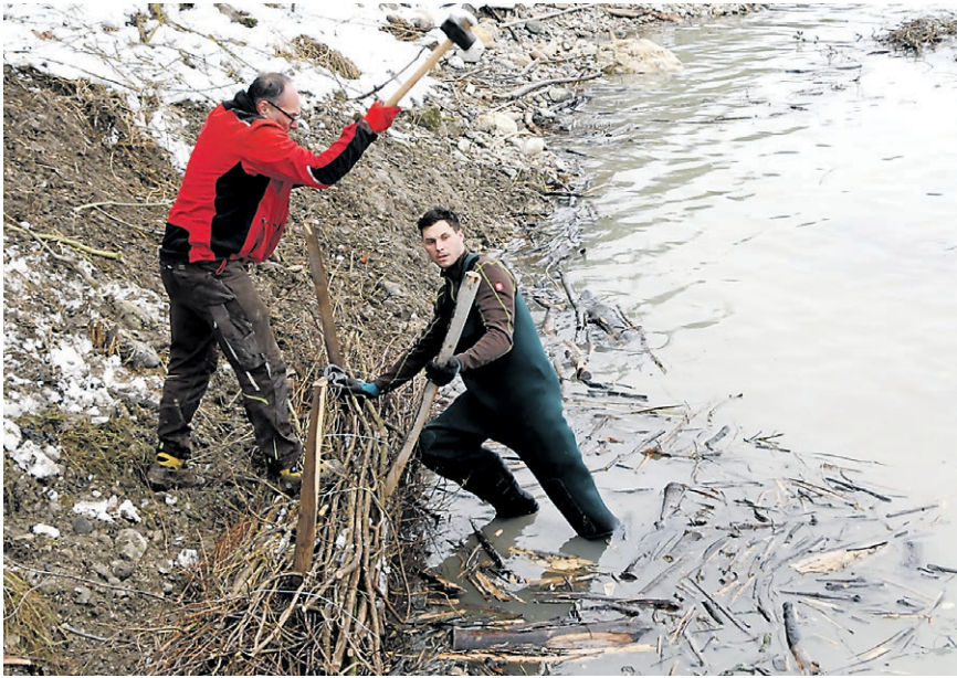
Manpower der Bäumig GmbH: Werner und Rico Schumacher verankern eine der Faschinen in der Uferwand. Bei Mittel- und Hochwasser bietet sie wertvollen Lebensraum.
